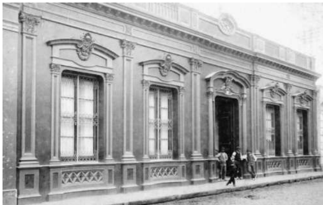
Fachada del "Club Fénix"
